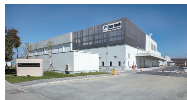
■ 三井艾喜緹機能膜股份有限公司 AP室改修工事(継続工事) 竣工(予定)年月:2024年11月 所在地:台湾 高雄市 建物用途:化学工場
