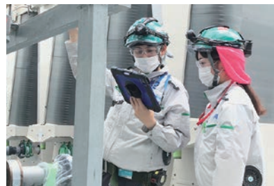
タブレット型端末による施工管理
