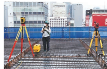
自動墨出しシステムによるレーザー墨出し
