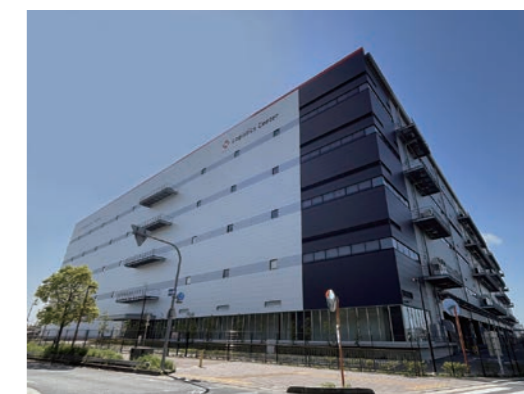
■ ニッセイロジスティクスセンター 大阪交野 竣工年月:2021年7月 所在地:大阪府交野市 建物用途:物流センター
