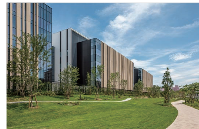
■ 中外ライフサイエンスパーク横浜 竣工年月:2022年10月 所在地:神奈川県横浜市 建物用途:研究所
