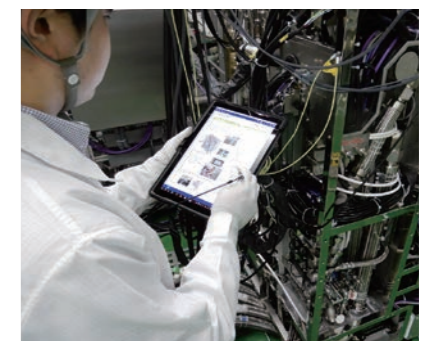
現場帳票電子化システムを活用した作業の様子
